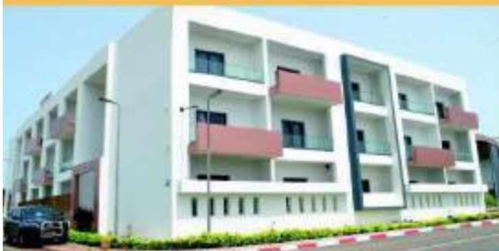
Batiment d'hébergement des stagiaires
